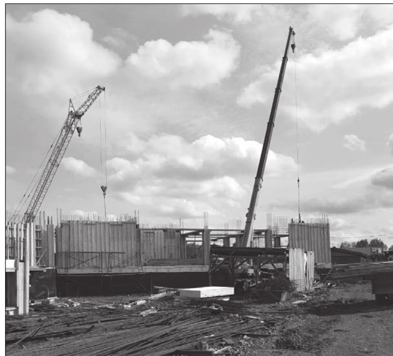
▲ Строительство здания школы № 10
